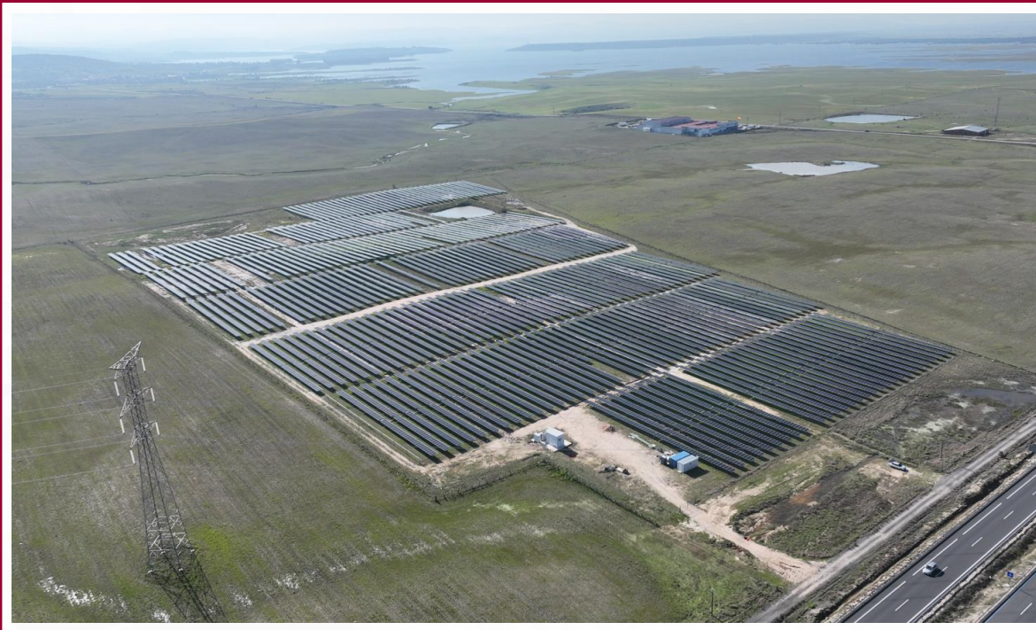
Parque de generación fotovoltaica Calzada Oropesa (Toledo) Potencia de 7,6 MW 17.136 módulos de paneles solares
